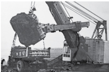
Исторический момент – 1 июня 1961 г. экскаватор взял первый ковш грунта с места будущего карьера
